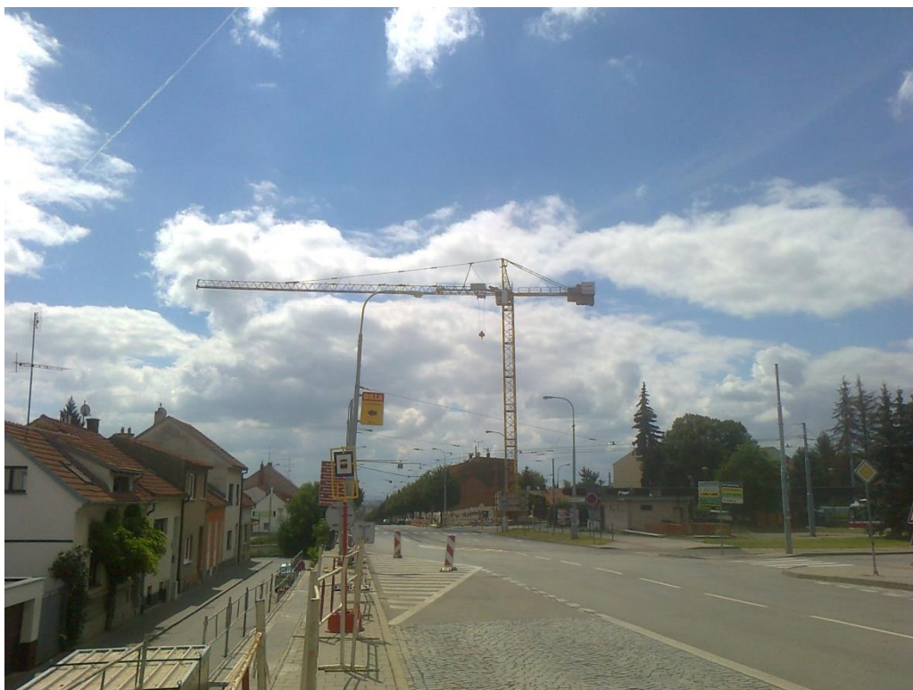
Obr. 5 18. červen Nad stavenišťe ční obrovský jeřáb, začínají stavební práce na základech a podzemních částech nového domu.
