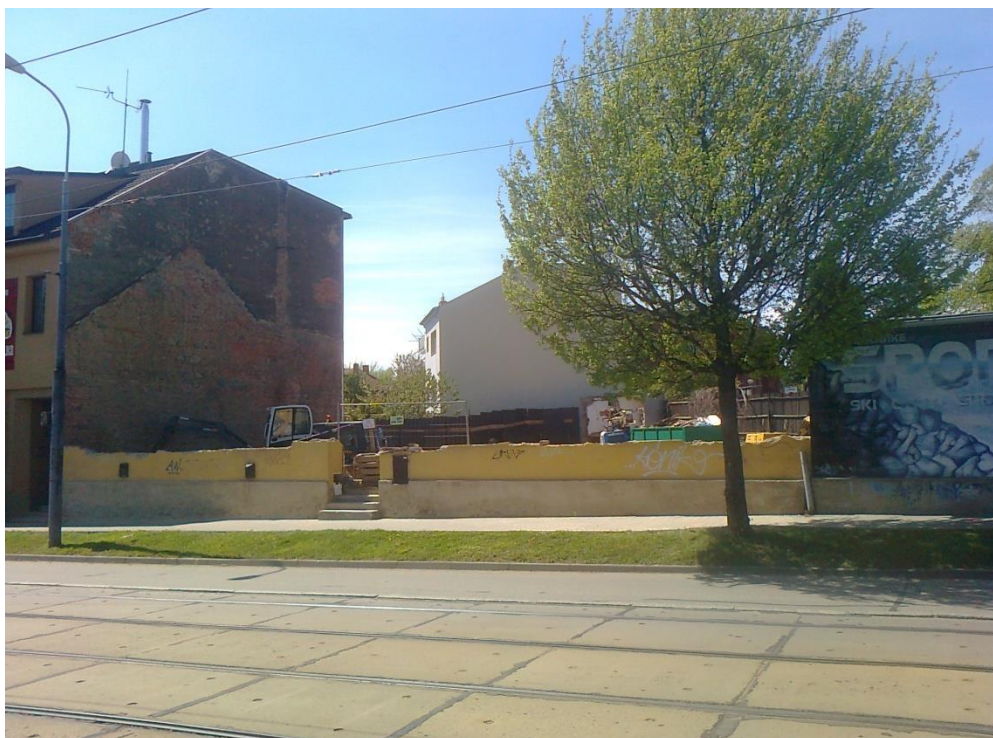
Obr. 3 7. květen Demolice domu Banskobystrická 1. Z původní stavby vyčnívá nad terén jen malá část navazující na základy
