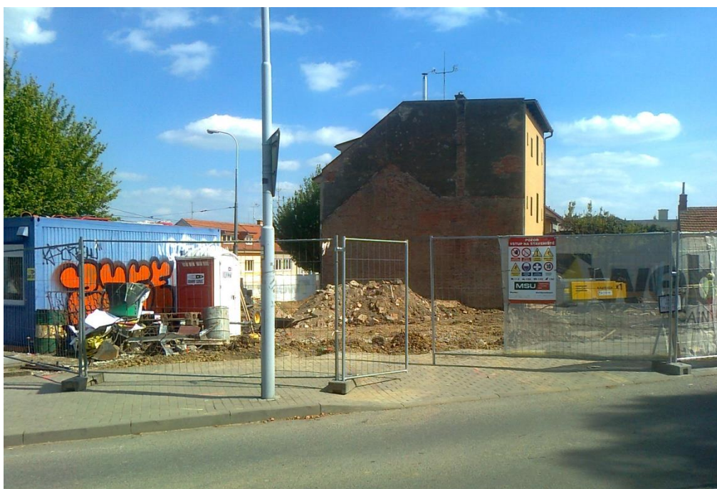
Obr. 4 10. květen Pohled do prostoru býv. domu Banskobystrická 1 od konečné zastávky tramvaje
