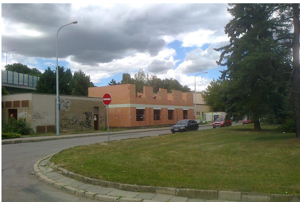
Obr. 8. Stavba podnikového objektu na ul. Karásek naproti budovy železniční stanice
