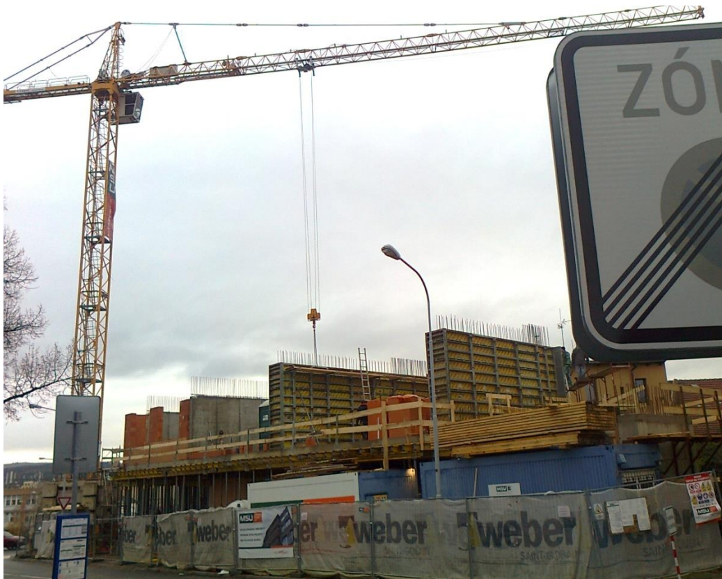
Obr. 7 20. listopad Stavba se konečně rozjela - i přes zbudované zástěny je vidět práce na 2. nadzemním podlaží
