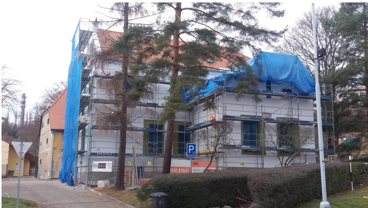
Obr. 9 Obecní bytový dům Palackého nám. 9 prochází generální rekonstrukcí (stav v prosinci 2017)
